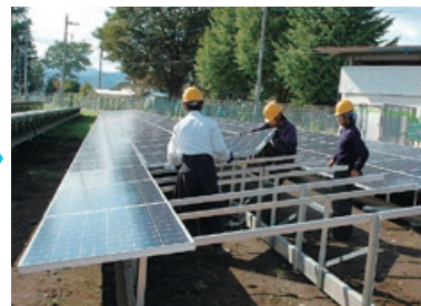
架台・パネル設置
